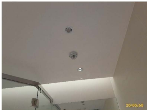
เครื่องตรวจจับควัน/เครื่องตรวจจับความร้อน
