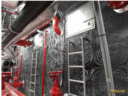
ถังเก็บน้ำสำรอง เพื่อใช้ในการดับเพลิง
