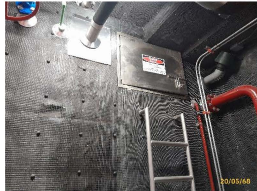
ถังเก็บน้ำสำรอง เพื่อใช้ในการดับเพลิง
