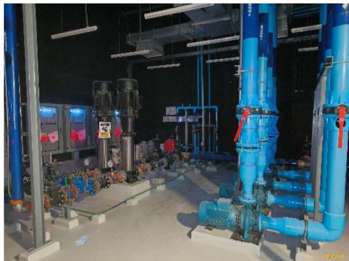
เครื่องจักรในระบบน้ำใช้ และแผงควบคุม (ใต้ดิน)
